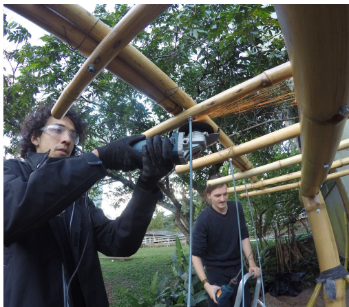
Figura 7: Construção do Telhado
