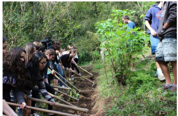
Construção do canteiro agroecológico
